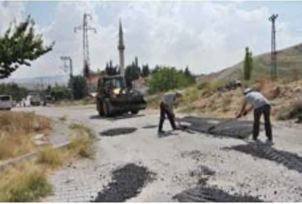
Asfalt ve yama çalışmalarından örnekler:
