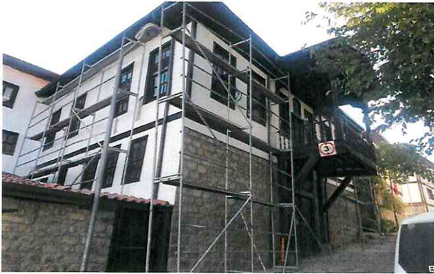
Yenice Sk. Doğa Evi Resterasyon dış cephe yenileme çalışmaları
