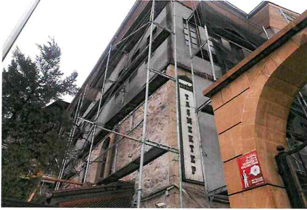
Taş Mektep Dış Cephe Yenileme Resterasyon Çalışmaları
