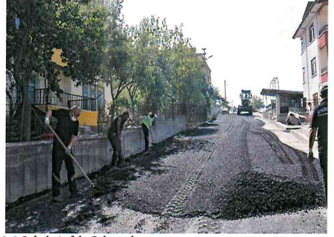
Ayvaşık Mahallesi Pınar 1-2-3 Sokak Asfalt Çalışmaları
