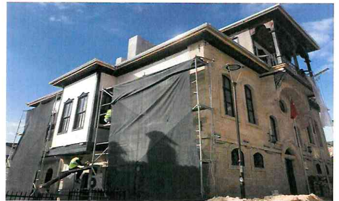
Limoncuoğlu Konağı Resterasyon dış cephe yenileme çalışmaları
