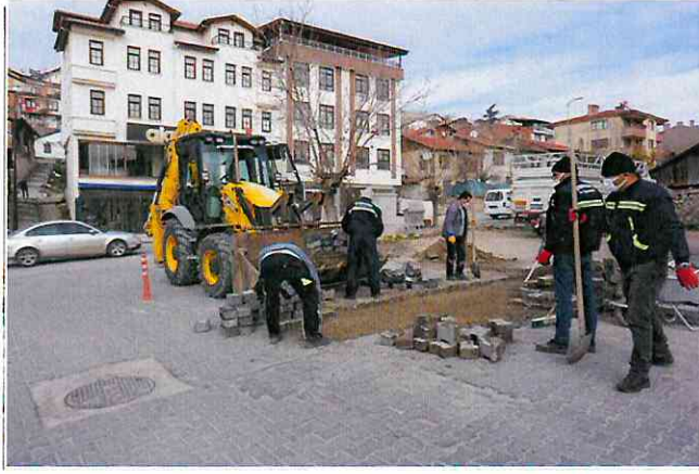
Kaldırım tamiratı çalışmaları
