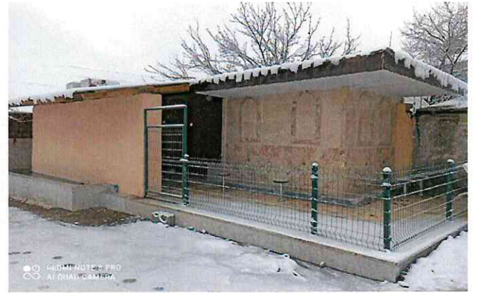
Köst Mahallesi "şadırvan yapım" işi tamamlandı
