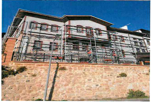
Taş Mektep Dış Cephe Resterasyon Yenileme
