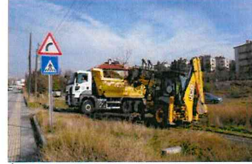
İnşaat Atığı Toplama ve Çevre Temizlik Çalışmaları
