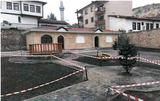
Kayhan Güven Caddesi ve Beytepe Sokakta bulunan muhtelif yapıların dış cephe onarım yapım işi kapsamında Suluhan Rekreasyon alanında "umumi tuvalet ve çay ocağı" yapılmıştır.
