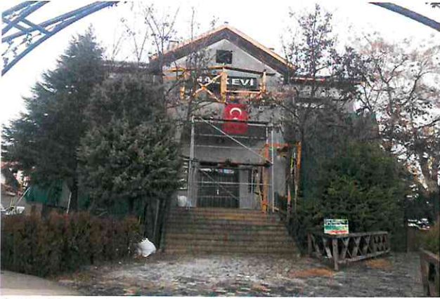
Halk Evi Dış Cephe Resterasyon Çalışmaları devam ediyor
