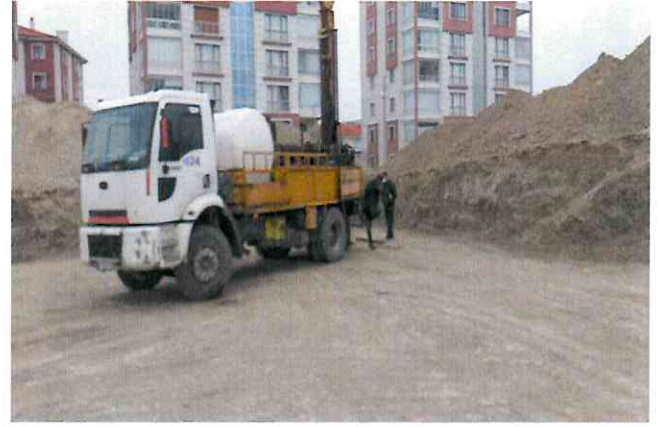
Kapalı Yüzme Havuzu Hafriyat Çalışmaları
