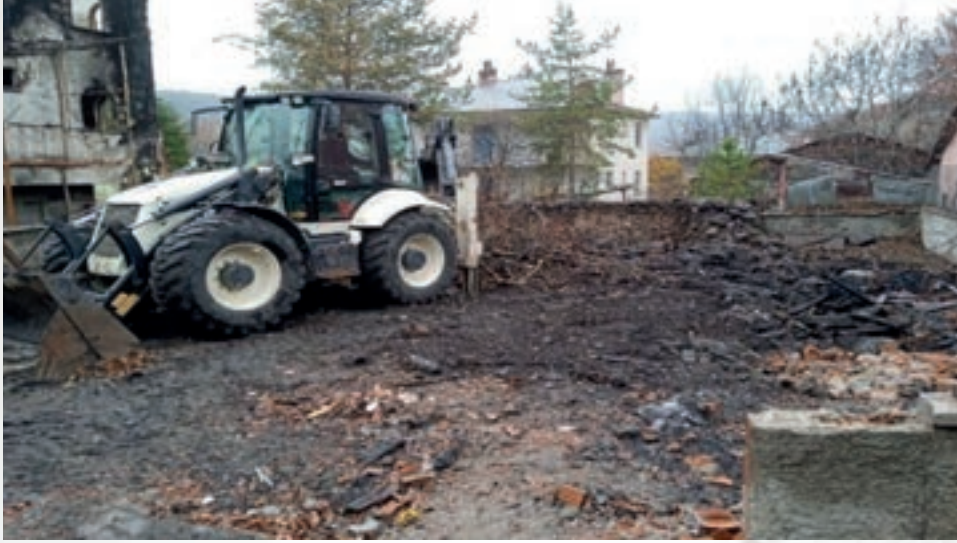
Saray Mahallesinde yanan evin enkaz çalışmaları.
