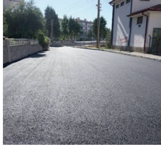
Hacıkara Mh. Tabaklar Cad. Mevlevi Sk. asfalt öncesi çalışma
