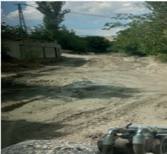
Yeşilağaç Mh. yol çalışmaları
