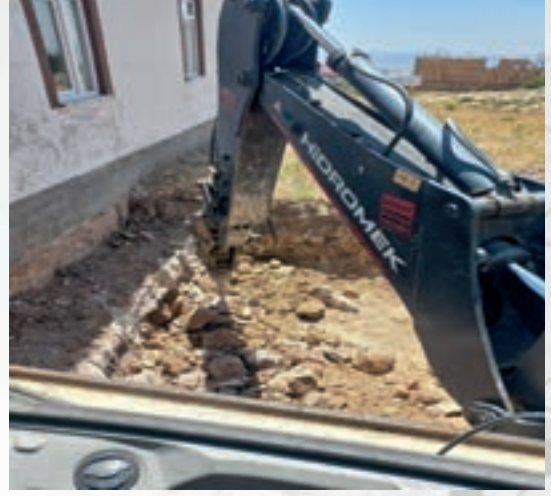
Kuyumcutekke Mah. cami minare temeli açımı
