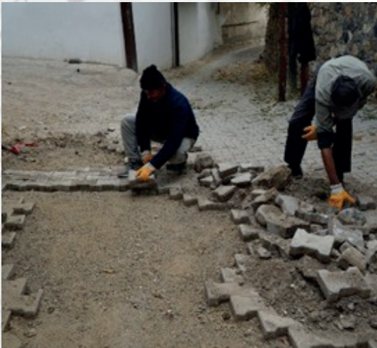
Rüstempaşa Köprübaşı Mh. kaldırım tamiri
