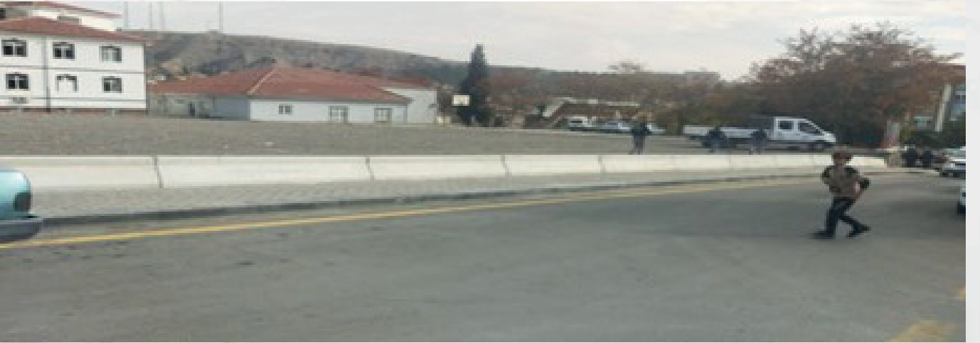
Beypazarı Ortaokulu bahçesine (malzeme serimi, yaya kaldırımı ve bariyer ) çalışmaları
