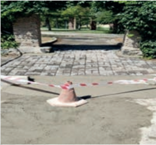
Bulgurdede Mh. park girişi engelli rampa yapımı
