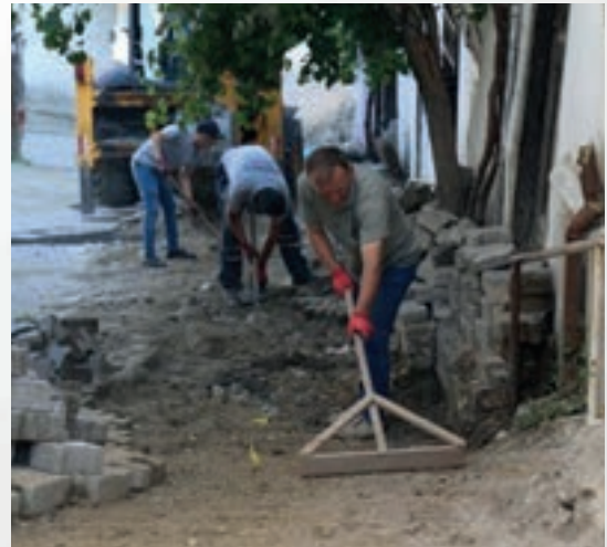
Zafer Mh. Dar Sk. kaldırım çalışması
