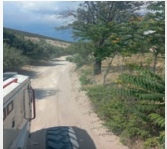
Eski Acı Mh. yol reglaj çalışması
