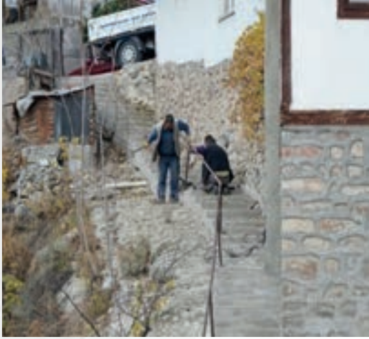
Karcıkaya Mh. merdiven ve korkuluk yapımı
