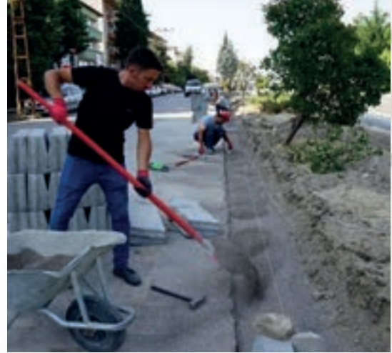
Hacıkara Mh. Alparslan TÜRKES Bulvarı bordür çalışması
