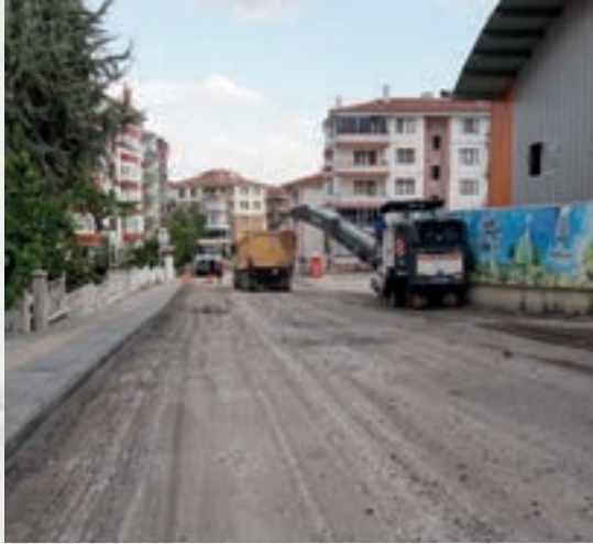
Hacıkara Mh. (pazar pazarı alanı yanı) asfalt öncesi çalışma
