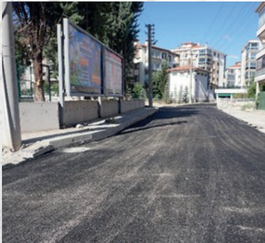
Hacıkara Mh. (Cevat KÖPRÜCÜ Sokağın devamı- halı saha yanı)
