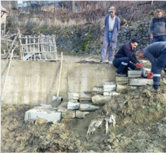
Karcıkaya Mh. merdiven yapımı
