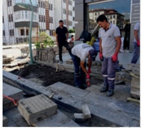
Hacıkara Mh. Cevat KÖPRÜCÜ Cad. yaya kaldırım çalışması
