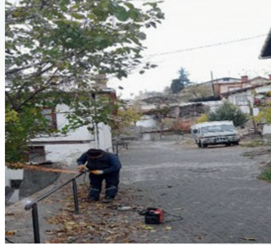
Zafer Mh. Hükümet Sk. demir korkuluk yapımı
