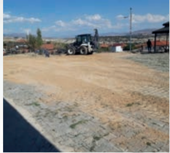
Macun Mh. Mahalle Konağı çevre düzenleme
