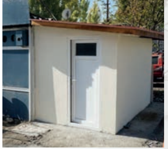
Yukarı Sanayi Umumi WC yapımı
