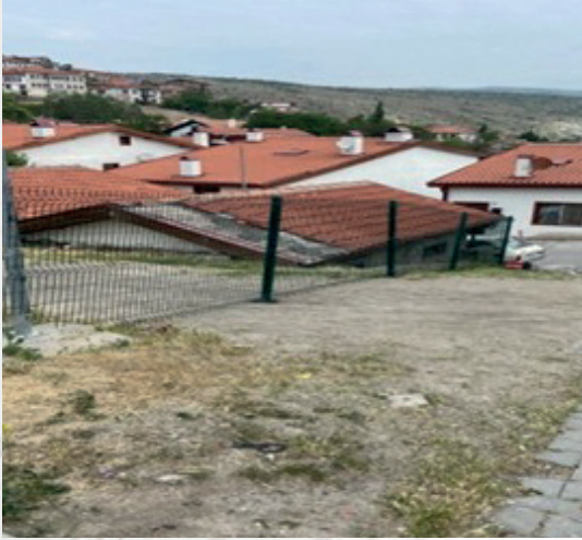
Rüstepaşa Mahallesi'nde bulunan dükkanların arka cephesi tel örgü çekilmesi
