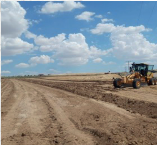
Tacettin Mh. TMO için döküm sahası reglaj çalışması
