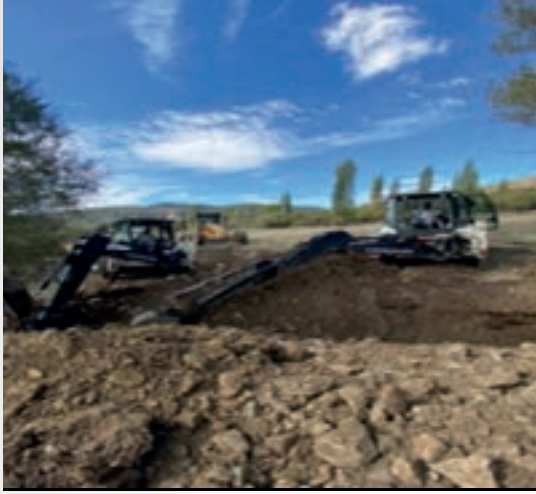
Kerbanlar Mh. arazi yolu bakım büz dözeme
