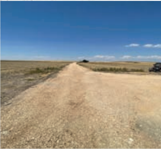
Dikmen Mahallesi malzemeli yol bakımı
