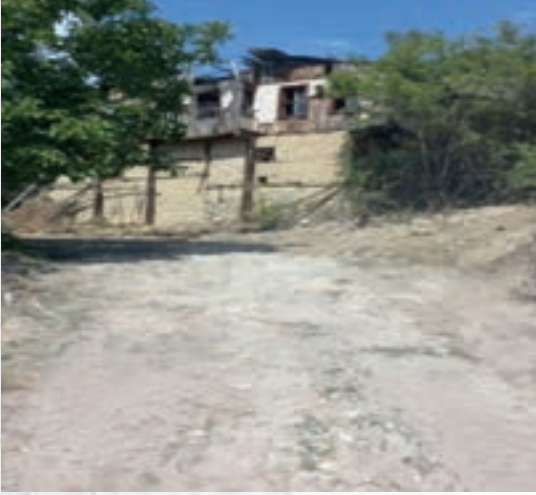
Başören Mahallesi yol genişletme çalışması
