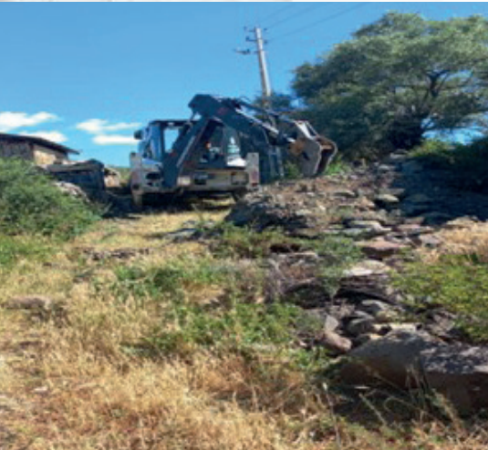
Karacaören Mh. kırıcı ile yol açma
