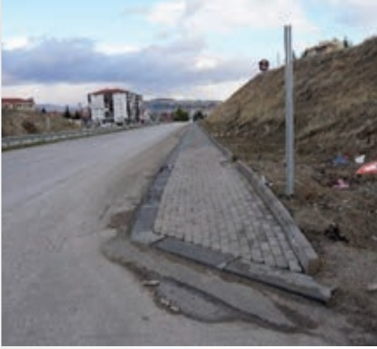
Başıağaç Mahallesi Alparslan Türkeş Bulvar kaldırım döşeme
