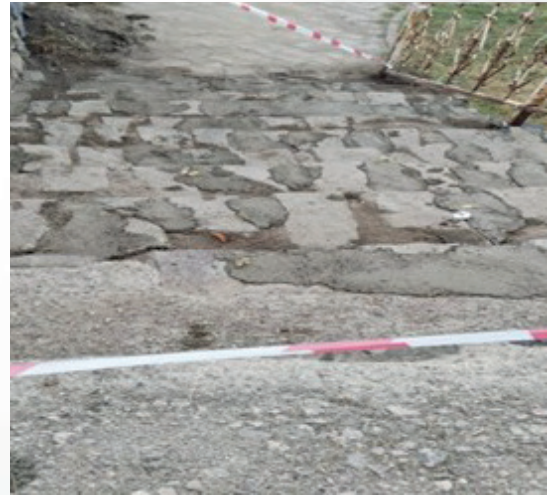
Hacıkara Mh. TKİ Lojmanları (Ocak evleri yanı) park merdivenleri
