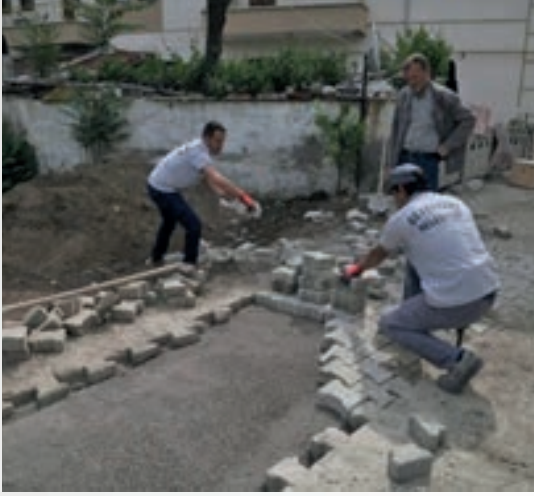
Hacıkara Mh. 109.Sk. yol iyileştirme
