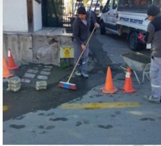
Engelli rampası yapımı (Kemal Milaslı Cad.)
