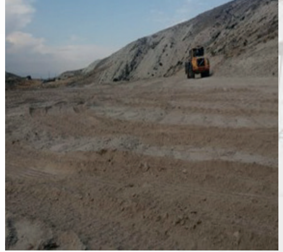
Mezarlık alanı genişletme çalışmaları
