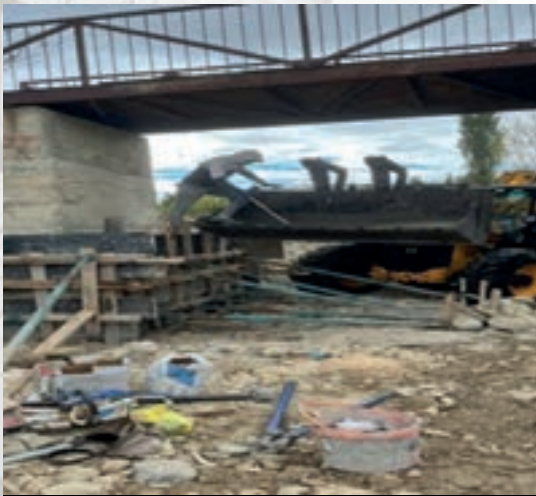
Bağdüzü Kooperatifi köprü ayağı güçlendirme
